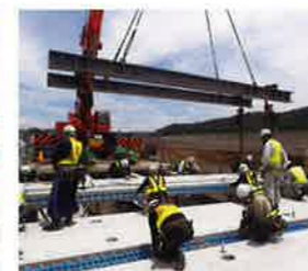
新しい床版の架設
