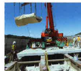
老朽化した床版の撤去
