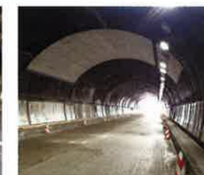
コンクリートの補強
