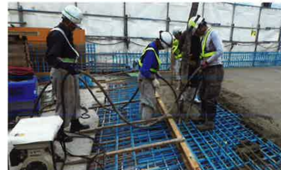
現場打ち床版の施工状況
