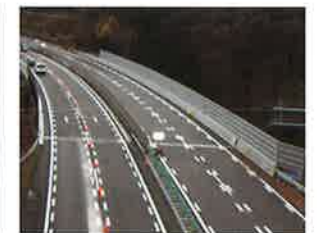
床版取替完了後
