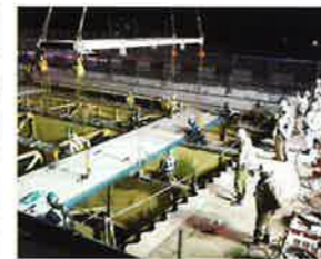
新しい床版の設置
