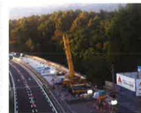
床版取替工事 全景
