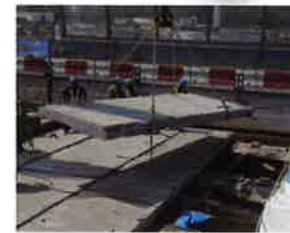
老朽化した床版の撤去
