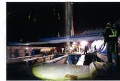
新しい床版の架設
