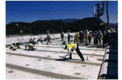
床版の間詰コンクリート打設
