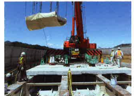
老朽化した床版の撤去の様子
